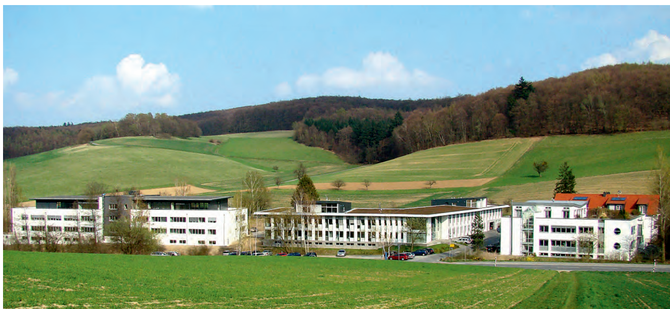
Siedziba firmy REA Elektronik GmbH, 30 km na południe od Frankfurtu nad Menem
